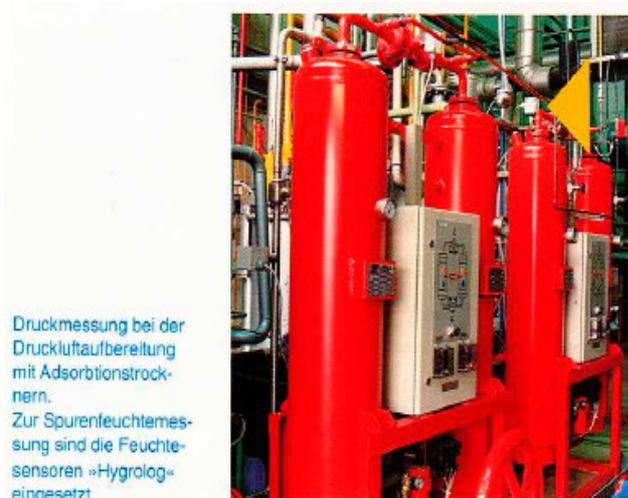
Druckmessung bei der Druckluftaufbereitung mit Adsorptionstrocknern. Zur Spurenfuchtemessung sind die Feuchte-sensoren »Hygrolog« eingesetzt.
