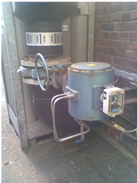
Endlagenrückmeldung mit Schlitzinitiatoren
