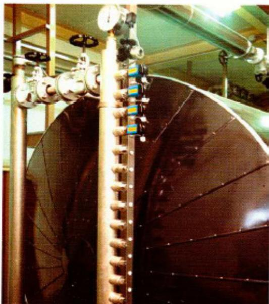
Realisierung von 4 unabhängigen Schaltpunkten mit Liquiphant-Vibrationssonden im Standrohr eines Sammelbehälters für Kesselspeisewasser
