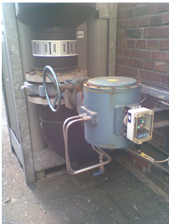
Endlagenrückmeldung mit Schlitzinitiatoren
