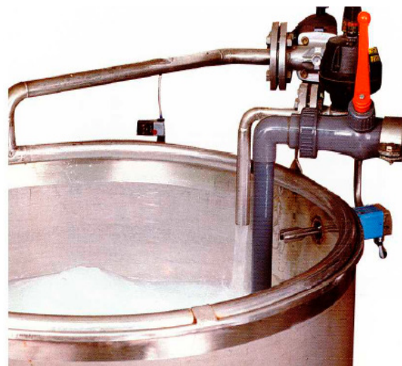
Grenzstandüberwachung mit Liquiphant-Sonden an einem Ansatzbehälter mit Rührwerk. Zuverlässige Funktion auch bei wechselnden Flüssigkeiten, unempfindlich gegen Turbulenzen, Strömungen und Schaum
