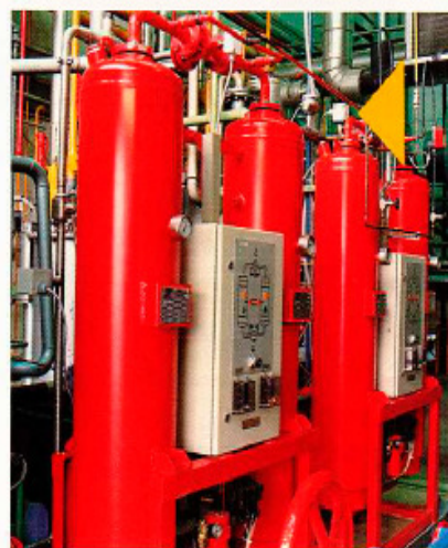
Druckmessung bei der Druckluftaufbereitung mit Adsorptionstrocknern. Zur Spurenfuchtemessung sind die Feuchte-sensoren »Hygrolog« eingesetzt.
